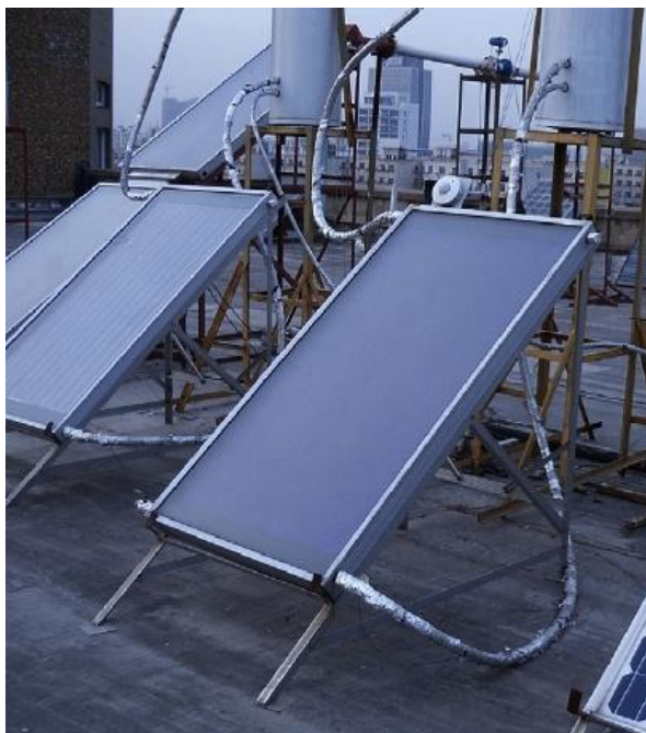
Slika 3.3. - pasivno hlađenje prirodnom cirkulacijom vode [29]
